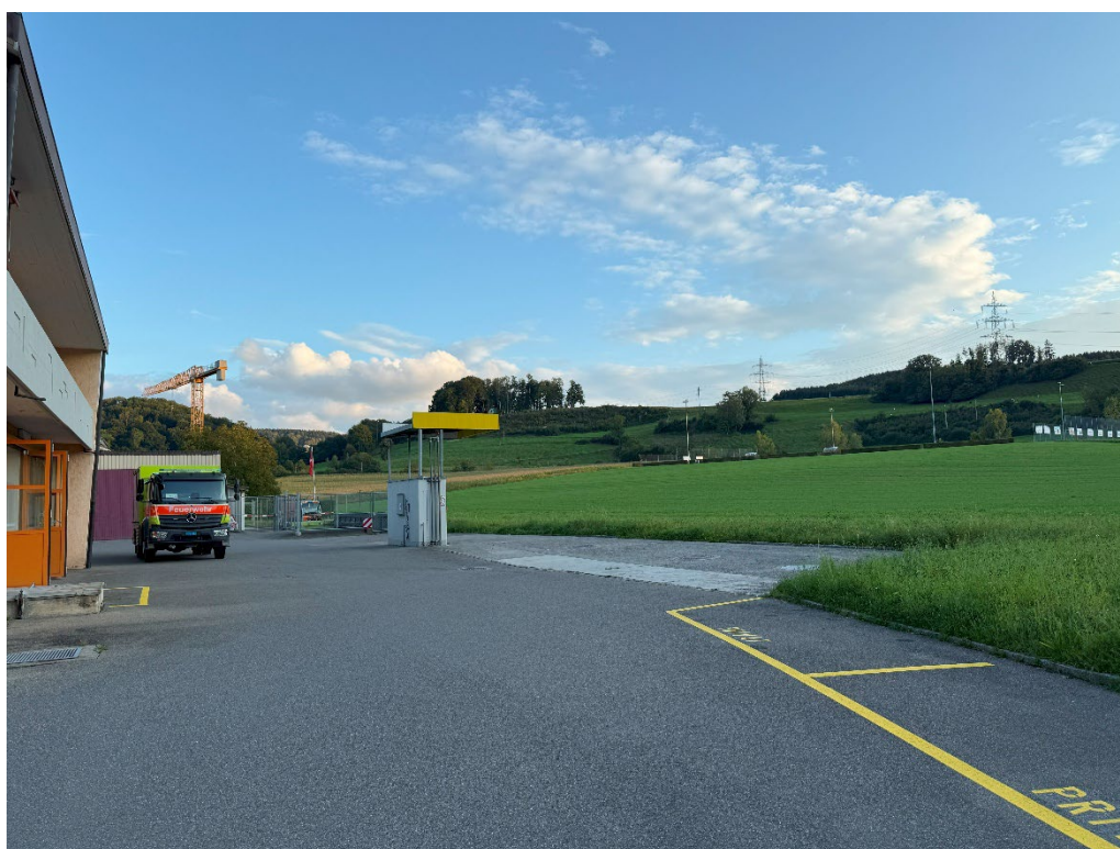
Blick auf das Wettbewerbsgrundstück, Birmensdorf 2025
